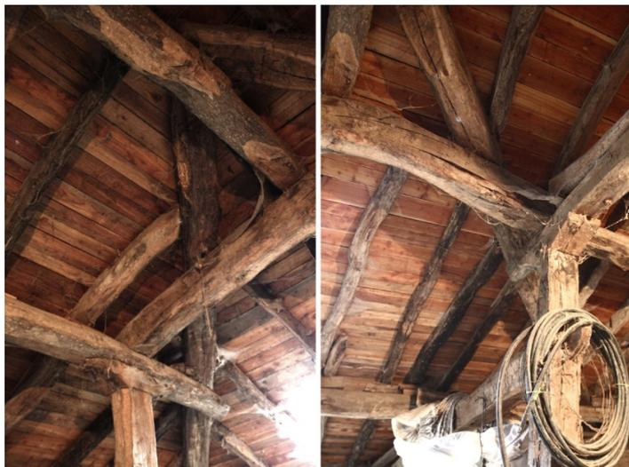
**Fig. 06.** Encuentros de vigas estructurales en el tejado del caserío Emparantza.
