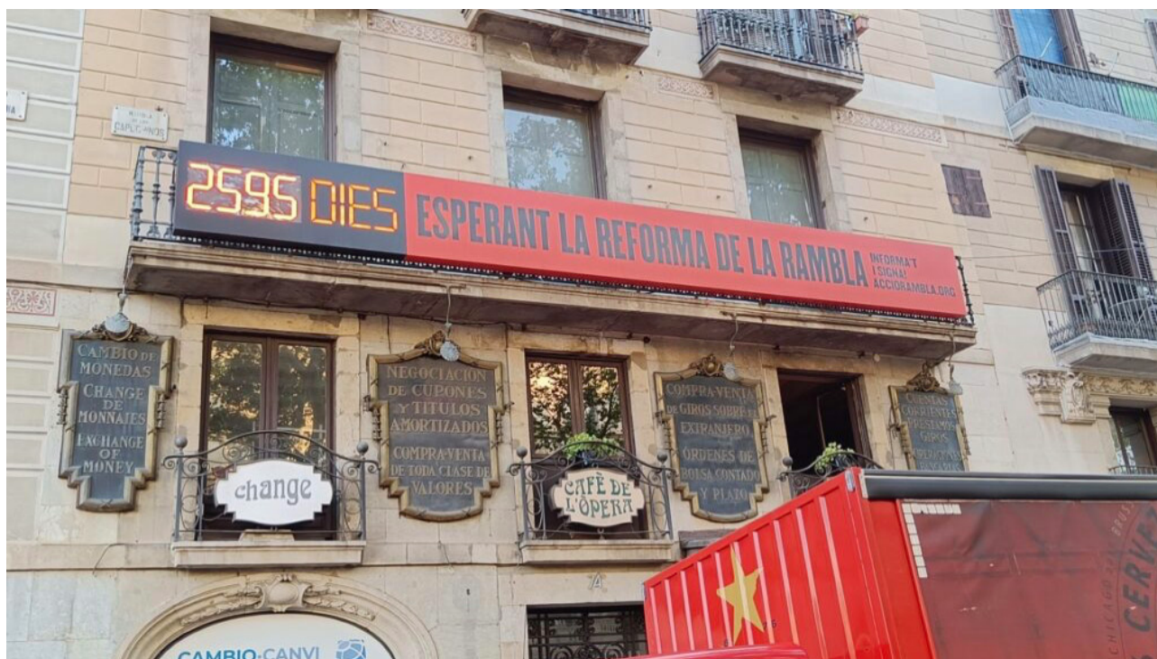
Imatge 5 | El comptador col·locat al número 74 de la Rambla, a l'edifici del Cafè de l'Òpera.
